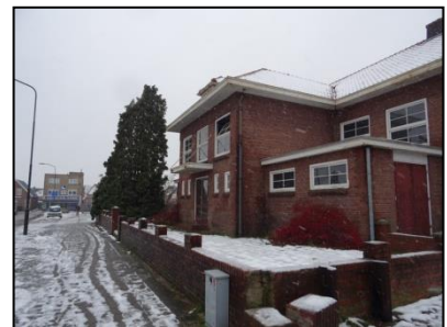
Figuur 5. Te slopen gymnastieklokaal aan de Jeugdkerkstraat met hoge spar.
