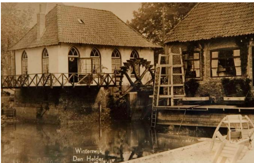
Afb. 15 Omstreeks 1925, wanneer de molen niet meer in gebruik is.. Goed is te zien hoe de vloer van de korenmolen oorspronkelijk hoger lag en de deur enkele treden had. Van de vakwerk-voorgevel van de oliemolen is nog net een glimp op te vangen.
