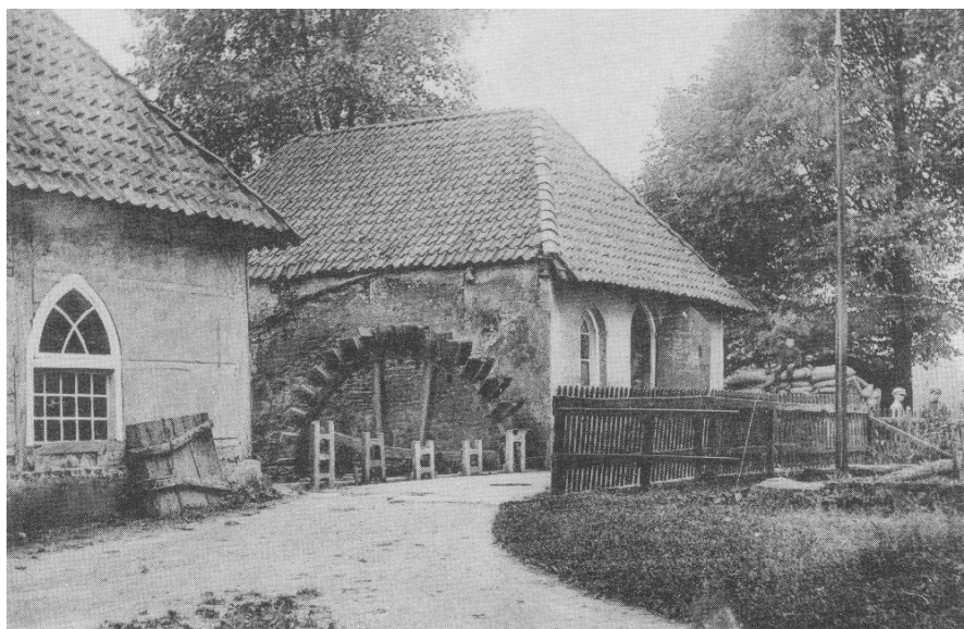
Afb. 11 Situatie in 1908. De oliemolen had nog een houten beplanking.
