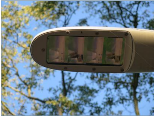
LED-verlichting lantaarn ontsluitingsweg.
