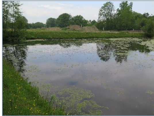
Westelijke deel van de retentievijver.
