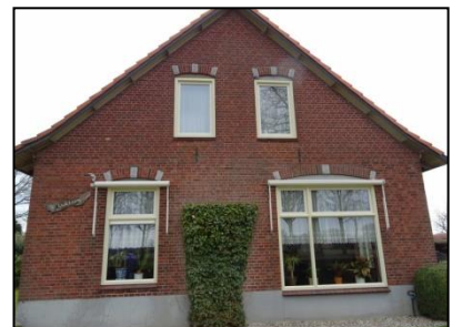
Figuur 8. Zuidgevel van de woning op de onderzoekslocatie.
