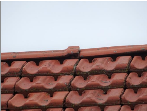
Figuur 11. Nokvorst van het dak met ruimtes waar vleermuizen onder het dak kunnen komen.
