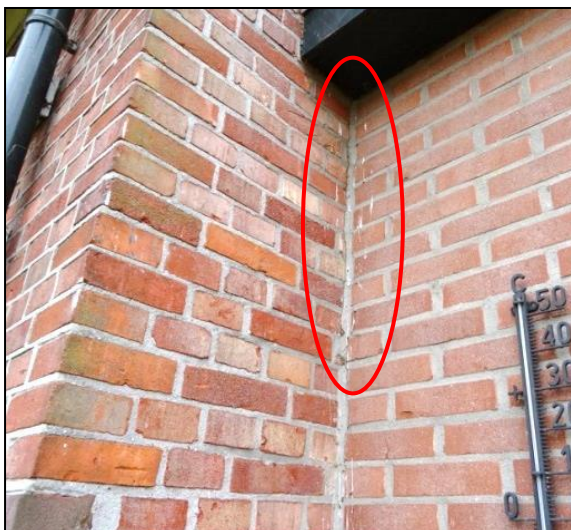
Figuur 10. Vogelpoep tegen de oostgevel van de woning.
