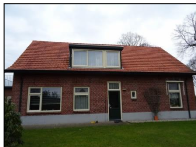
Figuur 7. Westgevel van de woning op de onderzoekslocatie.
