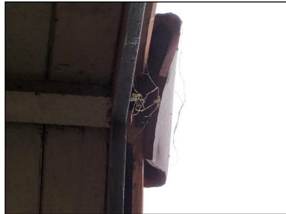
Figuur 12. Nokvorst op de kopgevel met ruimte van ruim een centimeter.
