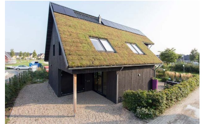
Sedumdak ↑ Zonnepanelen als onderdeel van het dak ↓
