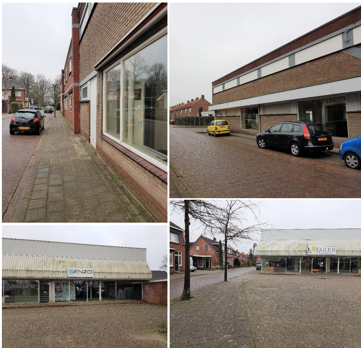
Figuur 2. Impressie van het projectgebied met de zijkant van het gebouw aan de Lijsterbesstraat (linksboven)
