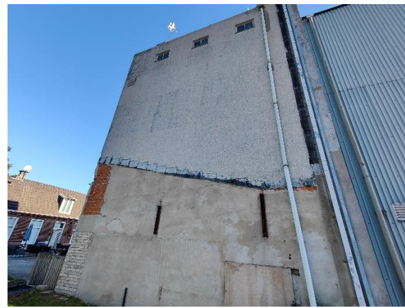
Figuur 6: Linker achter aanzicht Maalderij, betonnen structuur als genoemd bij f.
