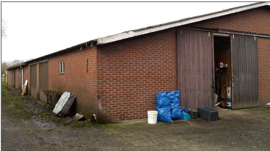
Foto: Stal zuidzijde (sloop)
