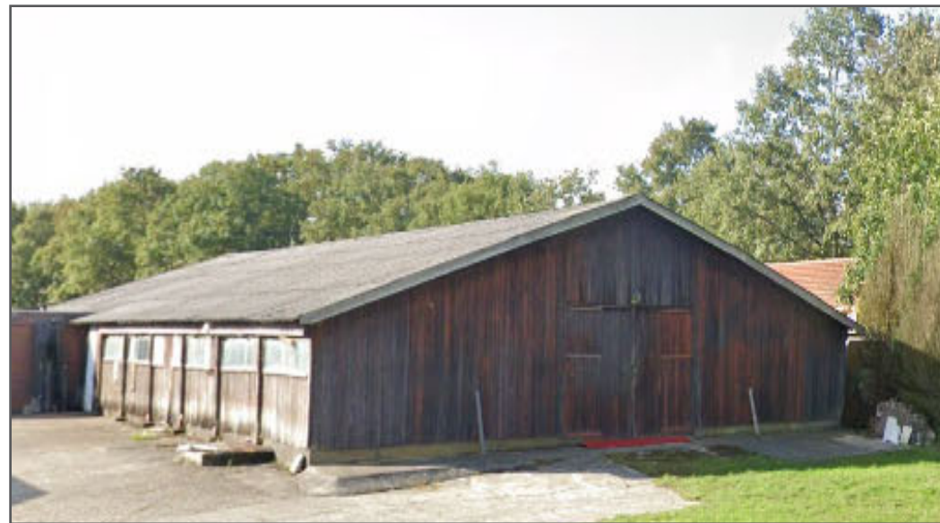
Foto: Stal noordzijde (sloop)
