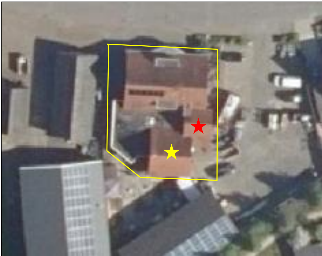
Ligging van het onderzoeksgebied; deze wordt met de gele lijn aangeduid. De beide te slopen bijgebouwen worden met de gele en rode ster aangeduid. Van het gebouw, aangeduid met de gele ster is het dak reeds verwijderd.
