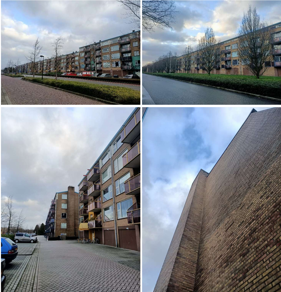
Afbeelding 4. Impressie plangebied, situatie op 21-02-2022. Linksboven een foto van de voorzijde en rechtsboven een foto van de achterzijde. Op de onderste foto's is de schoorsteen aan het meest westelijke complex te zien.
