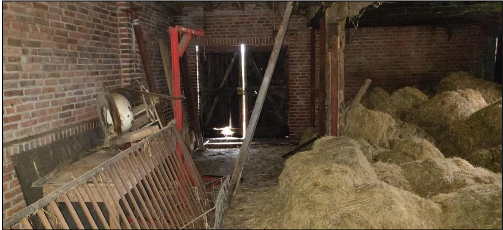
Westelijke helft van de schuur, met de stapel strobalen
