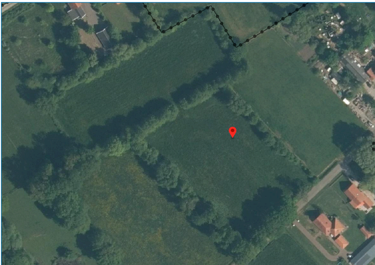
Afbeelding 4. Luchtfoto bestaande situatie plangebied (bron: Ruimtelijkeplannen.nl)
