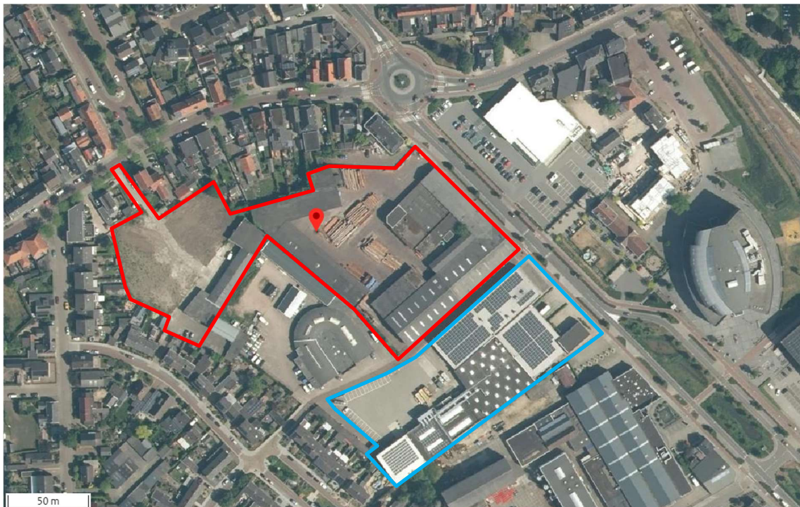
Figuur 2a: Overzicht locatie met de beoogde locatie voor de nieuwbouwwijk in rood kader. Arco Meubelfabriek is blauw omkadert.
