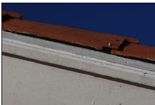
Ruimte achter overhangende dakpannen.
