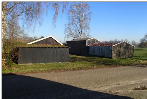
Opstallen in het plangebied.
