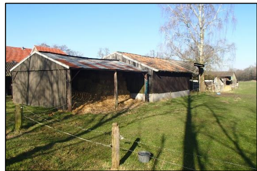
Opstallen in het plangebied.
