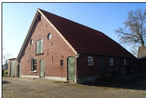
Noordelijke gevel van om te vormen stal met overhangende dakpannen.
