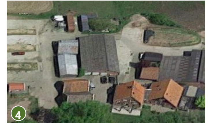
» Achter de woningen ligt een tweede schuur
