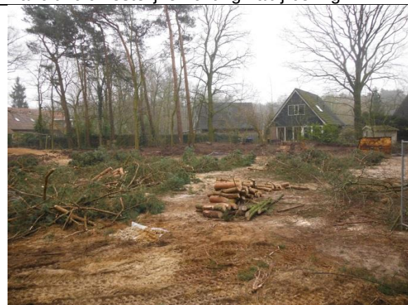
Vanuit noordwestelijke richting nabij boring 5
