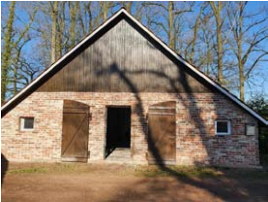
Foto's bestaande situatie
