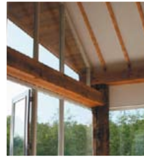
zichtbare (hout) constructie
