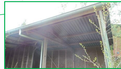
MM-31 golfplaten asbestvrij
