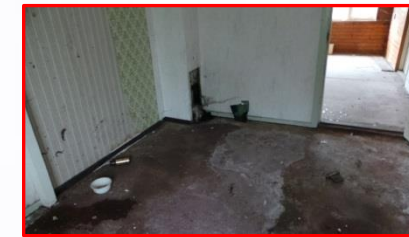
MM-37 losse plaat
