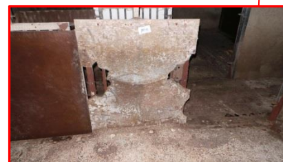
MM-11 schotten in de schuur
