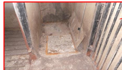
MM-18 losse plaat in de schuur
