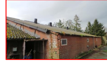
MM-29 golfplaten + gevels op dak van varkensschuur 4
