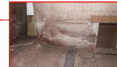
MM-23 schotten in de schuur
