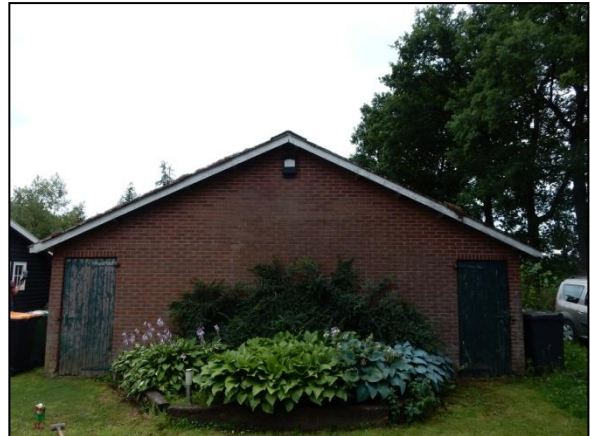
Figuur 21. Vleermuizenkast aangebracht op erf Bekeringweg 9.
