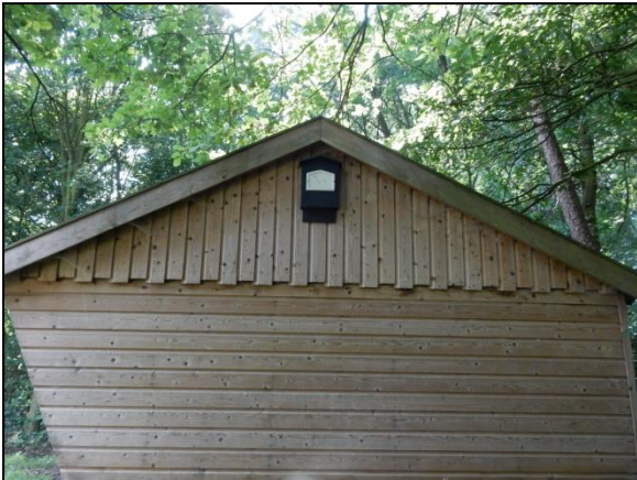
Figuur 20. Vleermuizenkast aangebracht op erf Bekeringweg 12.
