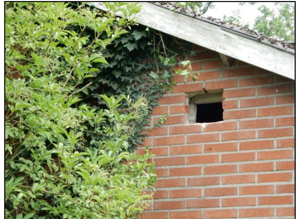
Figuur 18. Aangebracht "uilengat" in muurdeel van de schuur Bekeringsweg 20 zodat kerkuil toegang krijgt tot de kast.
