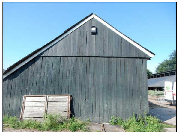
Figuur 23. Vleermuizenkast aangebracht op erf Bekeringweg 6.
