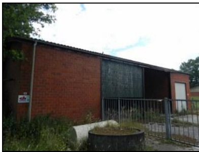
Figuur 3. Loods, noordelijk deel onderzoekslocatie.
