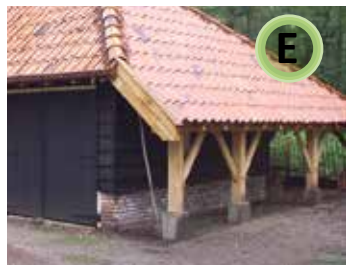
Aanbouw aan schoppe
