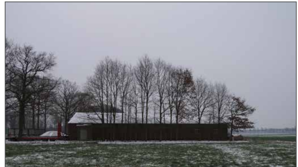
Afbeelding: Zicht op stal ten oosten van de planlocatie.
