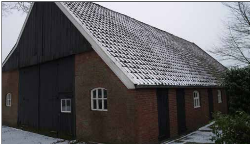
Afbeelding: Te slopen stal (locatie nieuwe woning)
