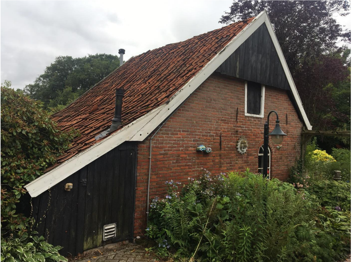
Foto van het te slopen gebouwtje.
