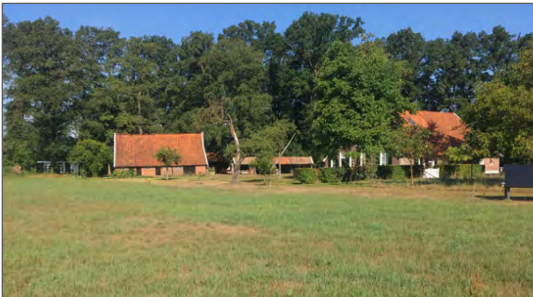
Foto: het erf vanaf de zuidzijde gezien, links de te verbouwen Schoppe
