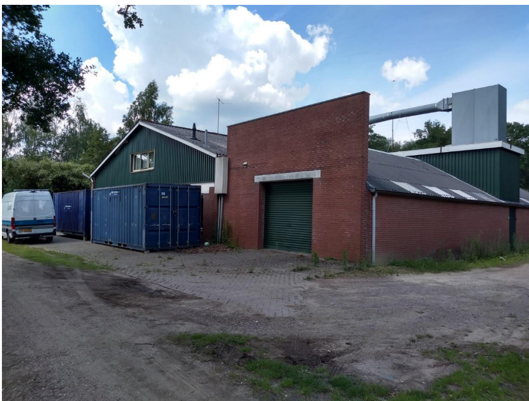
Afbeelding 10 Impressie van het plangebied. Foto van de aanwezige bedrijfsgebouwen genomen in noordwestelijke richting.
