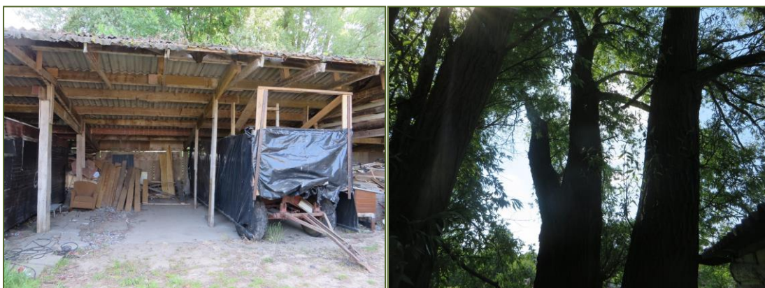
Foto's: Indrukken van de te slopen kapschuur en bomen achterzijde kapschuur.
