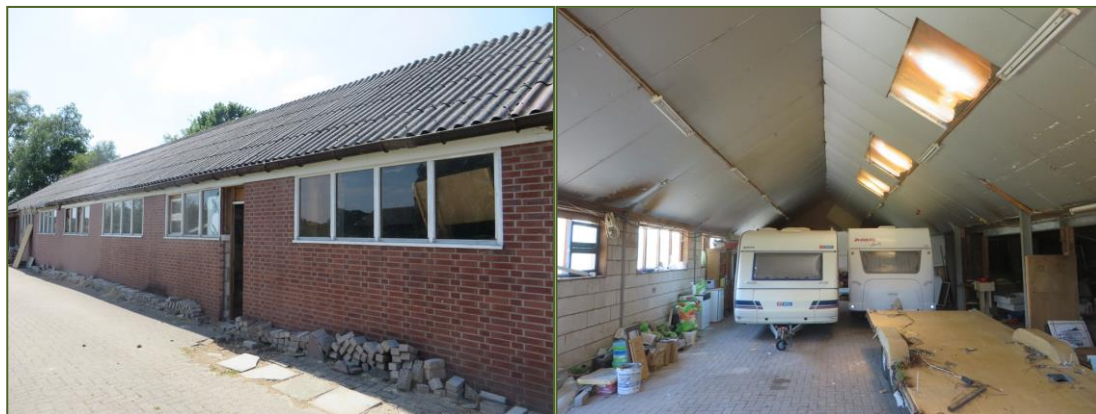
Foto's: Indrukken van de te slopen/ verbouwen schuur.
