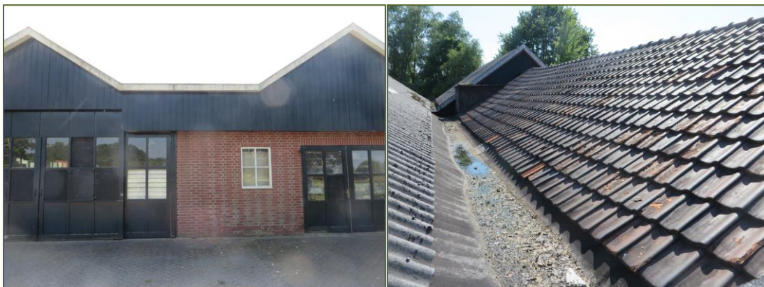
Foto's: Indrukken van de te slopen/ verbouwen schuren.
