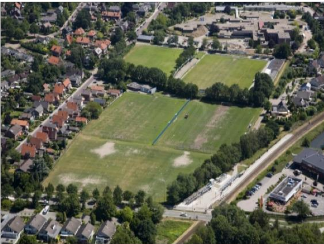
Afbeelding 2.3: Luchtfoto plangebied (Bron: IKZIEwinterswijk)
