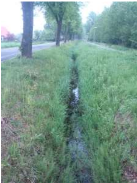
Foto 8: watervoerende sloot ten zuiden van de Whemerbeek. Bataafseweg ligt links, het vrij liggende fietspad rechts
