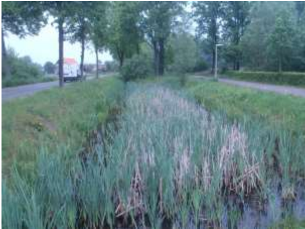
Foto 10: verbrede sloot / wadi ter hoogte van de sportvelden.
