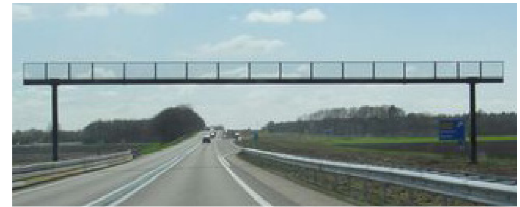
Voorbeeld van een tijdelijke voorziening om vleermuizen op voldoende hoogte de weg over te laten steken, zolang de beplanting nog niet hoog genoeg is.
