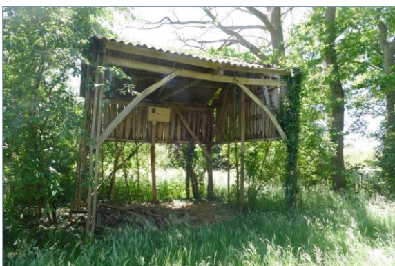
Foto 3. Kerkuilenkast in open kapschuur.
