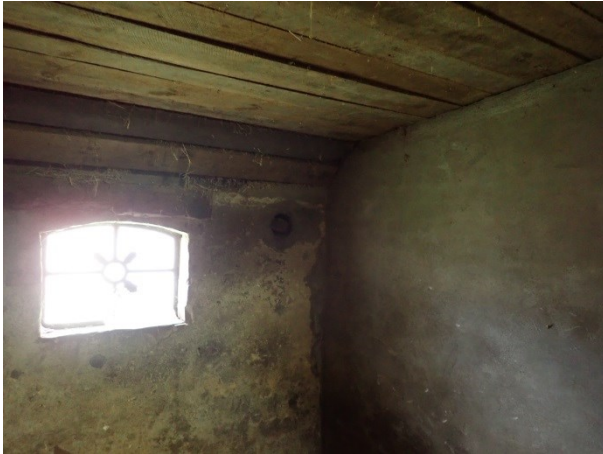
Foto 5: links, de gestuukte muren van de schoppe aan de binnenzijde
