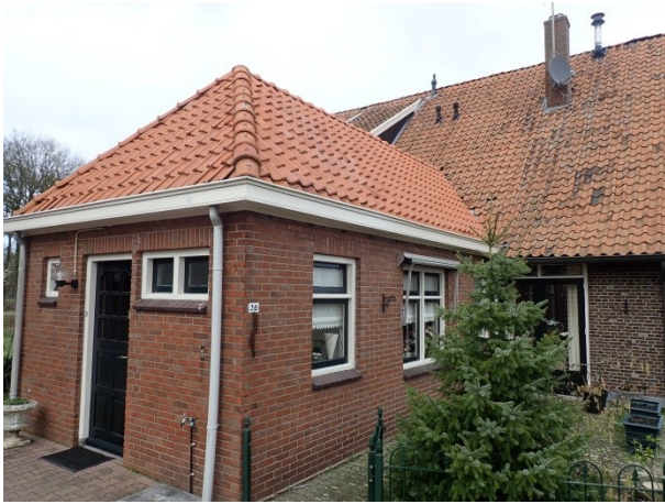
Foto 1: links, de te slopen aanbouw
