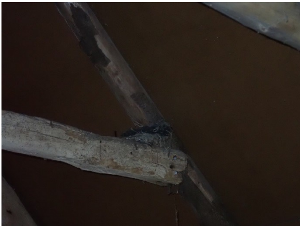
Foto 6: rechts, de zolder van de schoppe met de open voor en achterzijde
