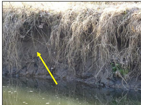
Figuur 12. Steile oever waar ijsvogels nesttunnels in kunnen graven.
