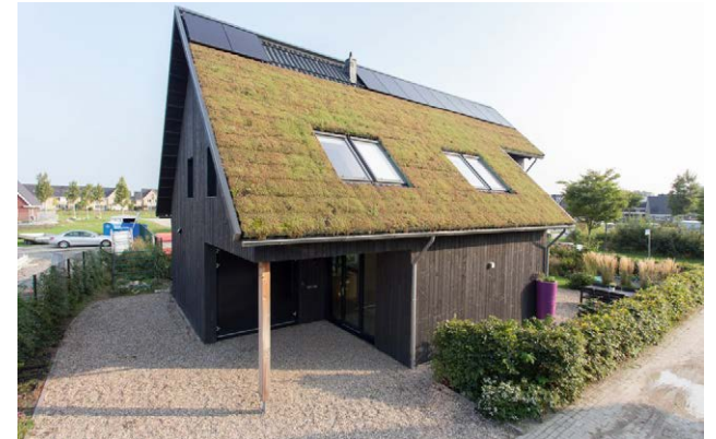
Sedumdak ↑ Zonnepanelen als onderdeel van het dak ↓
