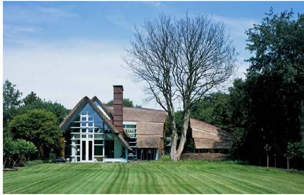
Bijgebouw en hoofdgebouw vormen ensemble ↑
