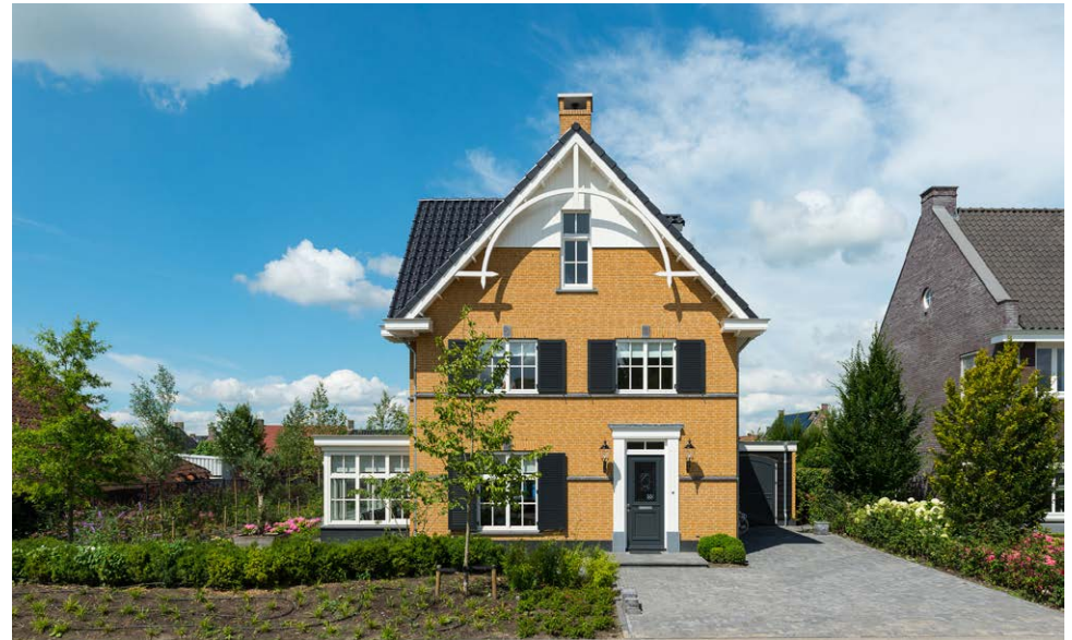
Gevelopeningen en detaillering creëren een herkenbare voorzijde
