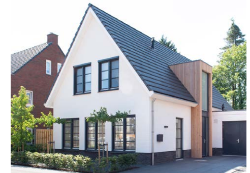
Zadeldak met verbijzonderde zijgevel
