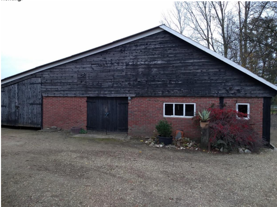
Afbeelding 21; Foto van het te slopen bijgebouw op erve Den Harden. De foto is genomen in noordoostelijke richting.
