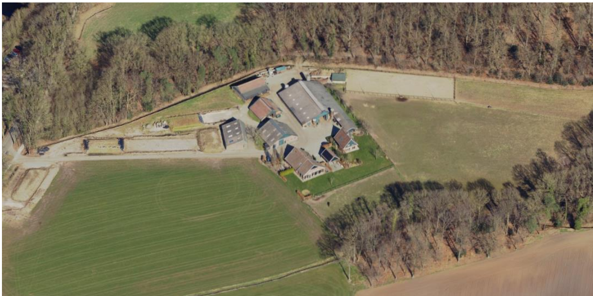
Afbeelding, bouwlocatie Wooldseweg 107-109 (Bron: Street Smart) opname: 10 maart 2022
