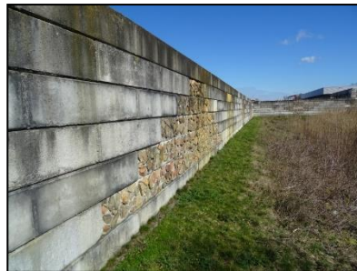
Figuur 4. Muur langs noordwestelijke en noordoostelijke oever van de retentievijver
