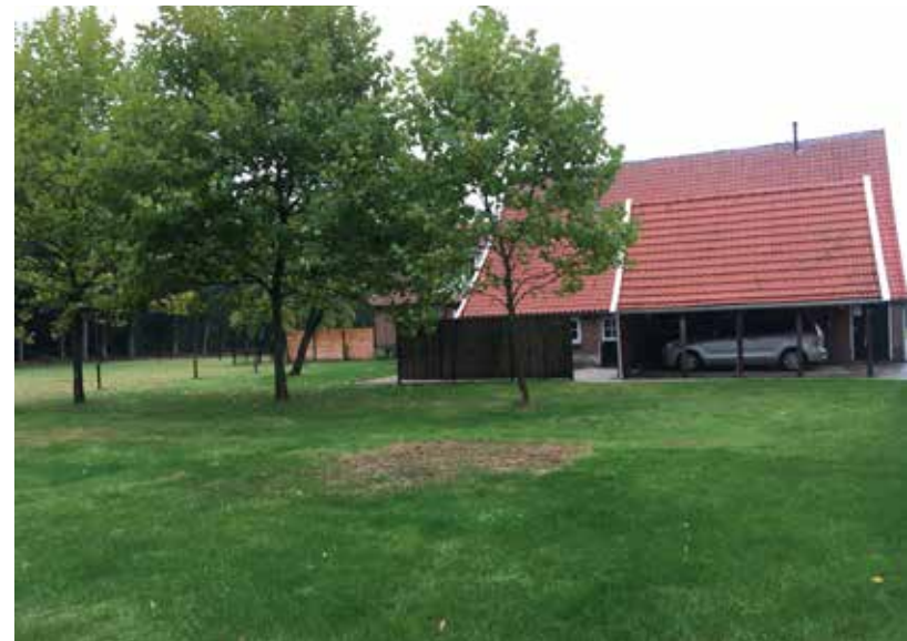
Foto: Woning B (met de te verwijderen schuttingdelen)
