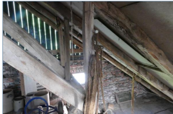
Foto 4. Detail van dak met spleten en nauwe ruimtes tussen de dakpannen en de houten binnenafwerking: geschikte locatie voor vleermuizen.
