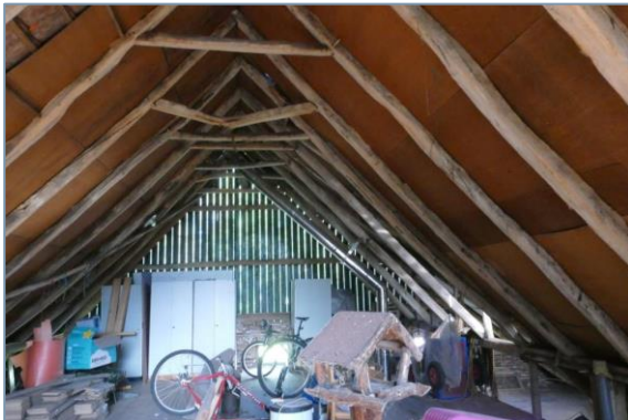
Foto 3. Dak van zolder met (deels) aanwezige dakplaten en openingen die toegang bieden tot de binnenruimte: geschikte locatie voor vleermuizen.
