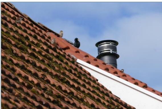
Foto 1. Huismussen en spreek op het dak van (het te verbouwen deel van) de boerderij.
