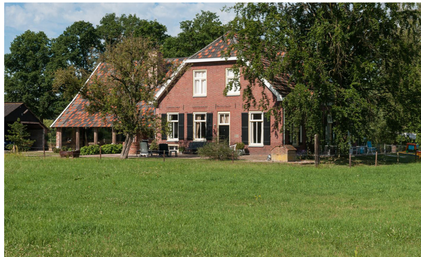
Figuur 11: Bestaande woning
