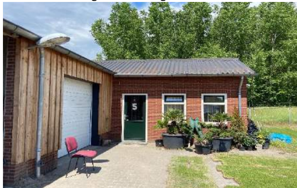
Figuur 2: Dakgoot met afvoer bebouwing voorzijde
