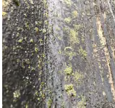
Nt codering golfplaten dak schuur 5
