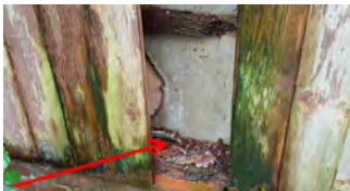
Bron 13 en MM-04 restanten in spouw linkerzijgevel
