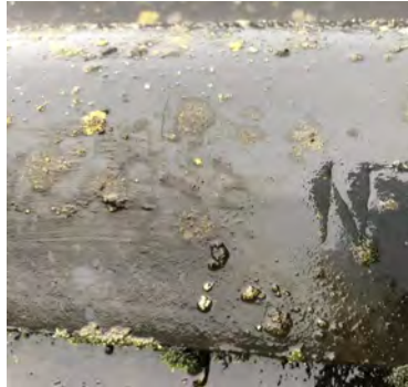
Nt codering dak schuur buiten onderzoeksgebied
