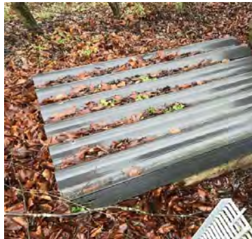
Asbestvrije golfplaten op mestplaat
