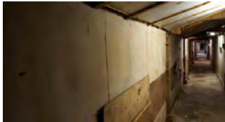
Bron 14 en MM-04 vlakke beplating binnenzijde schuur 4
