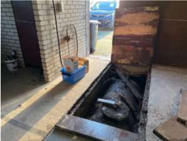
Figuur 11: Dieseltank in mestmengkelder
