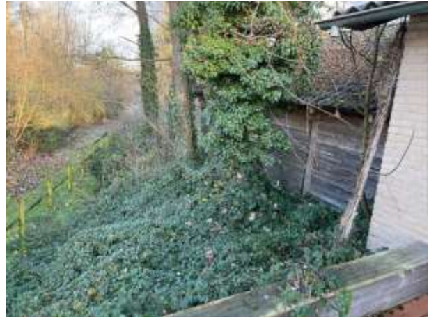
Figuur 12: Dak(goot) bebouwing
