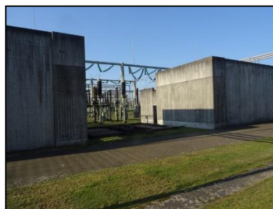
Figuur 4. Betonnen constructies ten zuiden van het bedrijfsgebouw.
