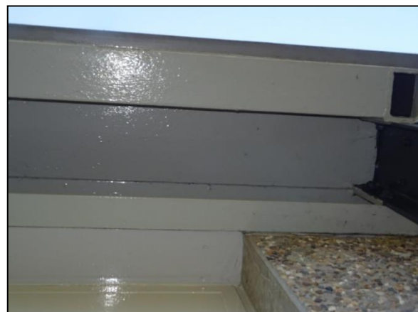
Figuur 11. Onderzijde van de overgang tussen de begane grond en de bovenetage.
