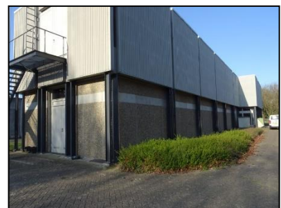
Figuur 5. Noordoostzijde van het bedrijfsgebouw.
