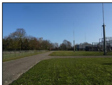
Figuur 7. Overzicht van de westzijde van de onderzoekslocatie.
