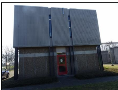
Figuur 3. Westgevel van het bedrijfsgebouw.
