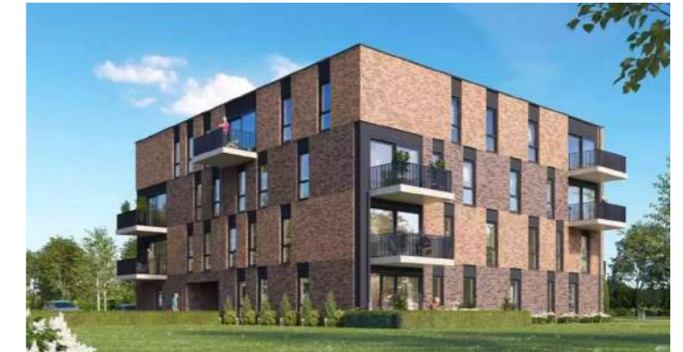
balkons versterken gevelgeleding en alzijdigheid
