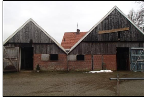
Stallen met dakpannen dak.
