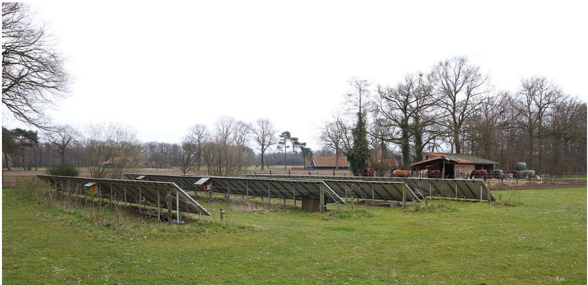
Foto 1. Zicht vanuit de noordwestelijke richting op het zonnepaneelveld aan de Sieverdinkweg in Kotten. De omvormers zijn achter/onder de panelen geplaatst. De grond tussen de onbeschermde panelen wordt door paarden begraaasd.
