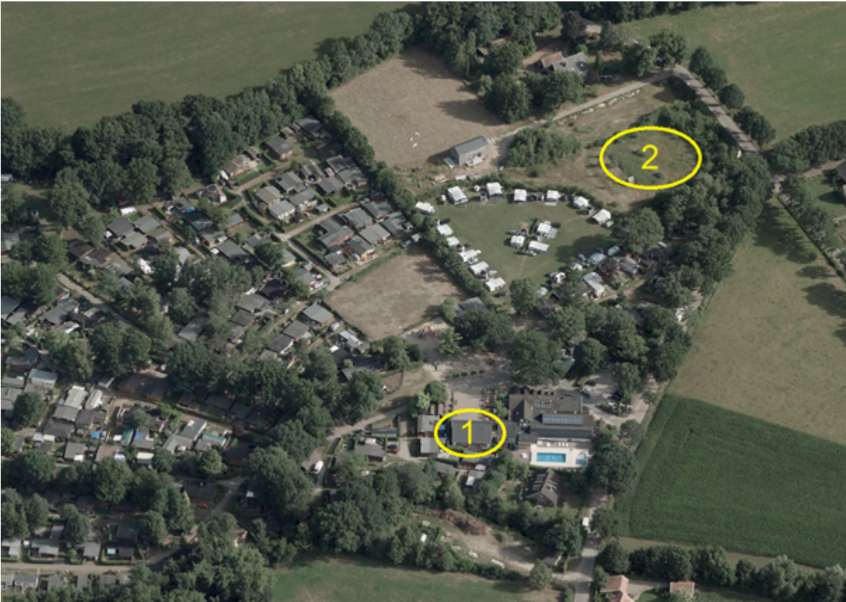
Luchtfoto met de locaties van de aan te leggen zonnepanelen (bron: Gemeente Winterswijk)
