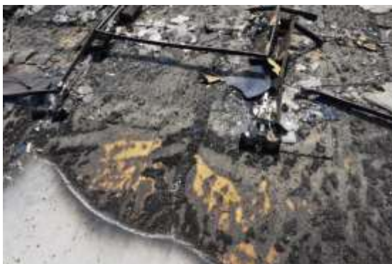
Afbeelding 3.4 Onbrandbare dakisolatie beperkt de brand op het dak (Bron: Tbo GM)
