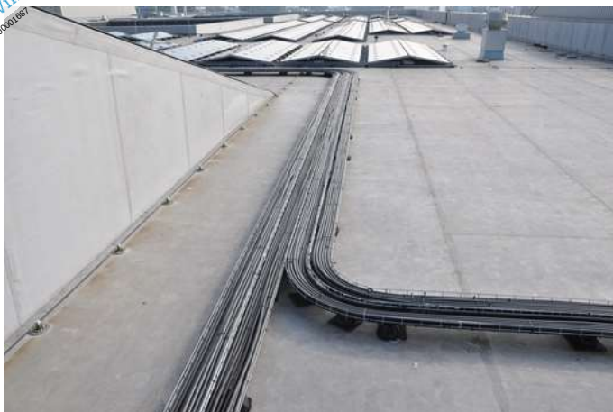
Afbeelding 1.2 Kabeltracé met transportkabels (Bron: TBO GM)
