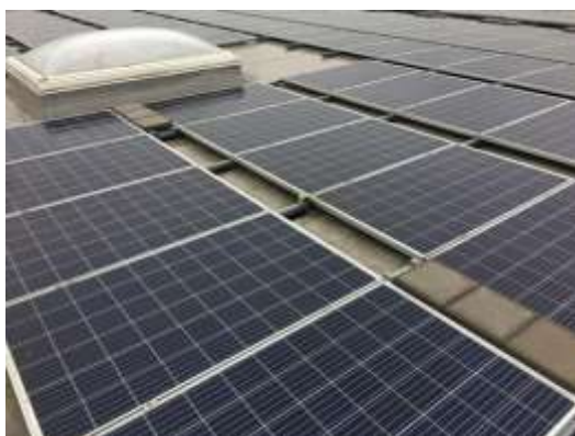
Afbeelding 3.2 Op-dak PV-systeem op een bedrijfshal, vlak vanwege windbelasting (Bron: Tbo GM)
