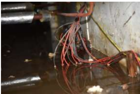
Afbeelding 3.10 Bekabeling met connectoren in een kruipruimte vol met water door een defecte pomp (Bron: Tbo GM)
