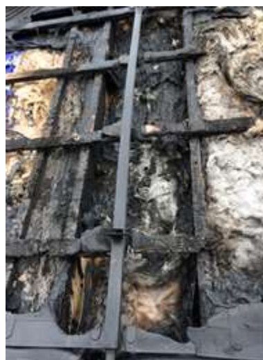
Afbeelding 3.3 Branduitbreiding over de brandscheiding heen. De panlatten zijn conform regels. Rechts: detail; dakpannen onderbroken (Bron: Tbo GM)
