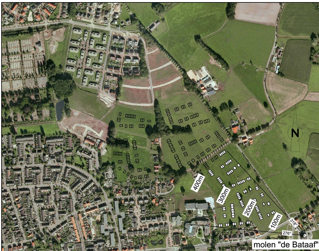
Figuur 1: Luchtfoto met situatie bouwplan De Rikker ten noordwesten van de molen. (bron luchtfoto: Google Earth pro)
