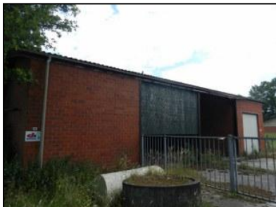
Figuur 3. Loods, noordelijk deel onderzoekslocatie.
